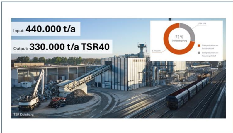
Abb. 16: Höchste Recyclingqualität spart CO 2 bei der Stahlproduktion – TSR liefert zertifiziertes Inputmaterial für Stahlwerke.
