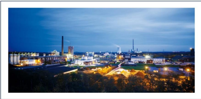
Abb. 7: Lippewerk von REMONDIS in Lünen.
