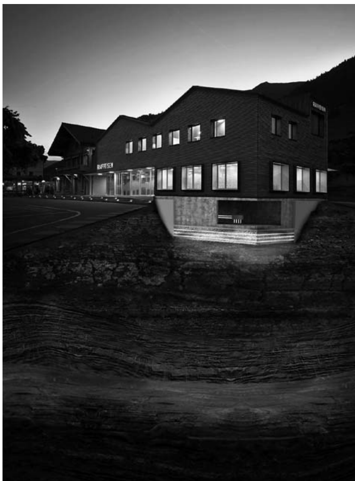
Abbildung 2: Bankgebäude Raiffeisenbank in Chateau d'Oex, Schweiz (Baujahr 2009). 2-geschossiger Flachbau in Massiv- und Holzbauweise, Vollkeller. Beheizte Fläche 740 Quadratmeter; Heizlast 17 kW; Solar-Hybridanlage Gesamtgröße 86 Quadratmeter; Erdwärmespeicher eTank 340 Kubikmeter der deematrix Energiesysteme GmbH Fürstenwalde. Das Gesamtsystem arbeitet unter Verwendung einer Wärmepumpe nach der offenen, oszillierenden Pufferspeichertechnik (ooPS©), einer Entwicklung der eZeit Ingenieure GmbH, Berlin. (Animation: eZeit Ingenieure GmbH, Architektur: architecum GmbH, Foto: A. Gempeler)
