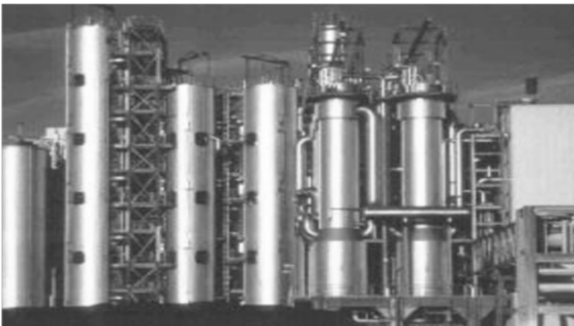
Abbildung 6: Kontinuierliche Kristallisation mit Doppeleffektverdampfung im energiesparenden Verbundsystem
