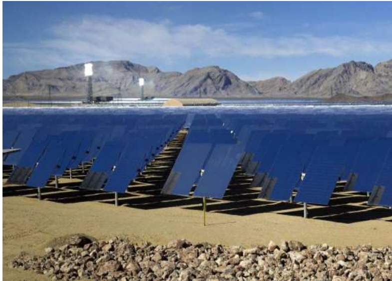
Solarkraftwerk Ivanpah (Ca), 1400 Hektar, 350000 Spiegel
