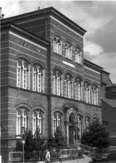
Gebäude des pharmakologischen Instituts der Universität Greifswald
